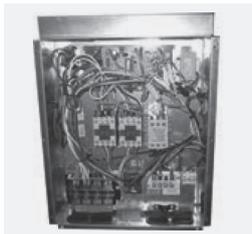
Многофункциональный блок управления осуществляет безопасное управление работой компонентов и узлов компрессорно-конденсаторного блока, контроль и индикацию их состояния.
